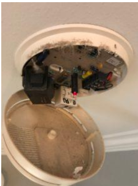
Рисунок 5 – Грязь на чувствительном элементе дымового извещателя приводит к ложным срабатываниям.
